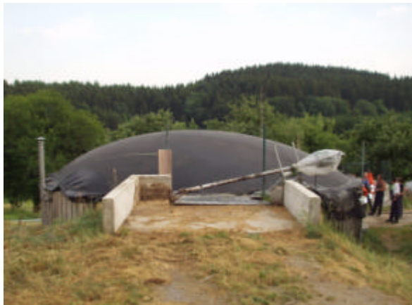
Image 1: Digesteur équipé d'un stockage souple (membrane EPDM) avant la test au feu.
